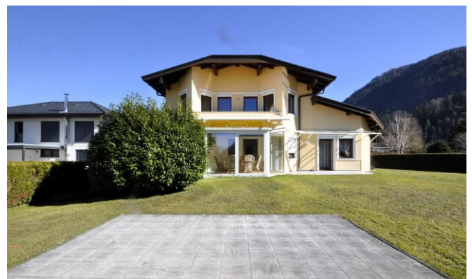
KUNDL - Einfamilienhaus - Hausansicht Richtung Südwesten
